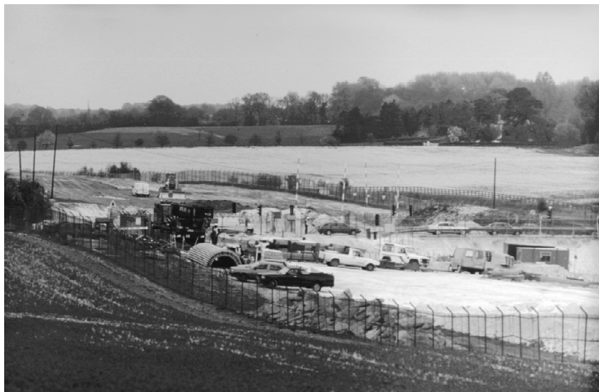
Ogrodzony metalową siatką teren budowy obwodnicy w Newbury.
