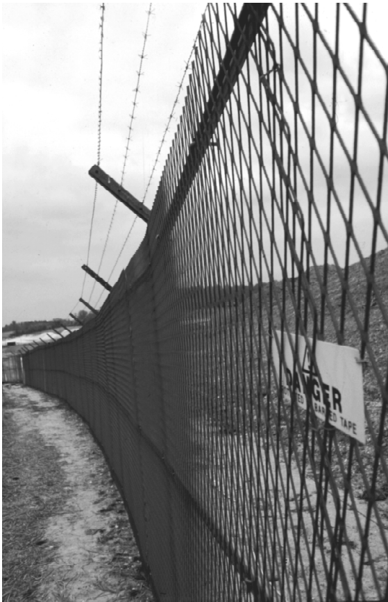
Ogrodzenie terenu budowy może mieć kilkanaście kilometrów długości.
