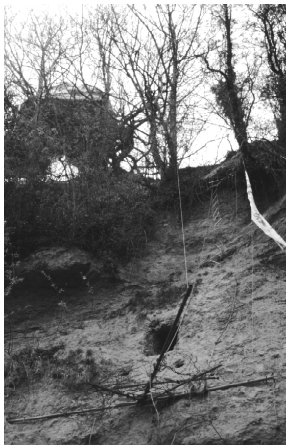
Wejście do tunelu usytuowane w skarpie – obóz Cliff Richard .
