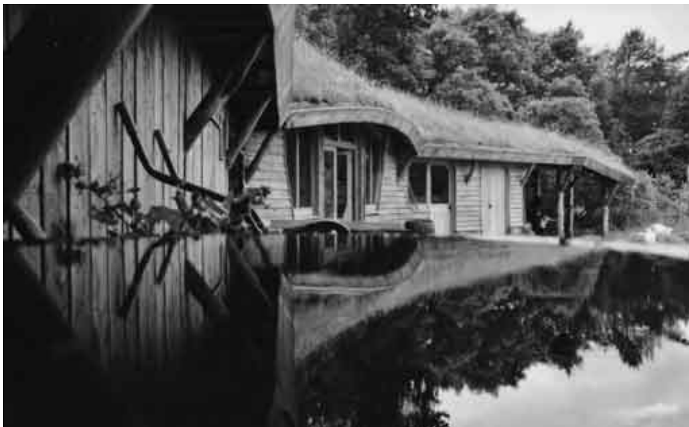
Life Centre Trust (Fundacja Życia) w Pishwanton (Szkocja). Główna sala przykryta jest łupina siatkową, która została wykonana przy użyciu najprostszych narzędzi i materiałów.
