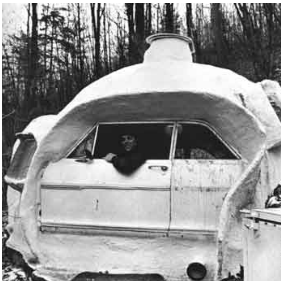
Dom Billa Beneta - kolejny przykład możliwości recyklingu samochodów. Ściany wykonane są z ferrocementu – siatki metalowej obłożonej cementem.
