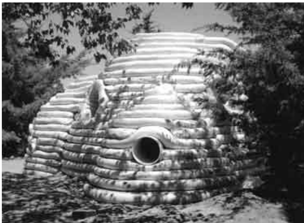
Technologia Superadobe opracowana przez Nadera Khalili w założonym przez niego centrum Cal-Earth.
