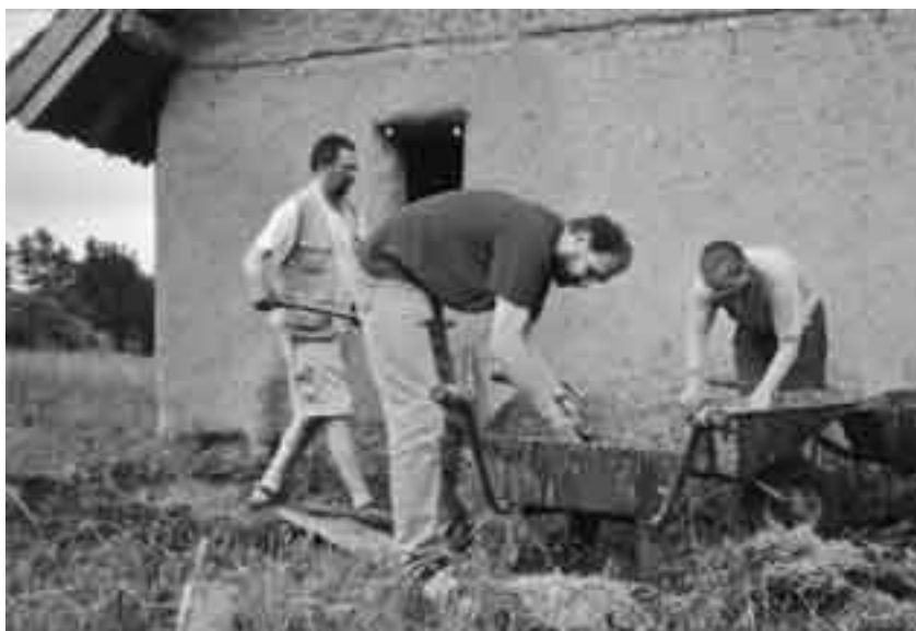
Budowa pierwszego polskiego budynku z kostek słomianych tynkowanych gliną. Przelomka koło Suwałk. Proj. Paulina Wojciechowska.
