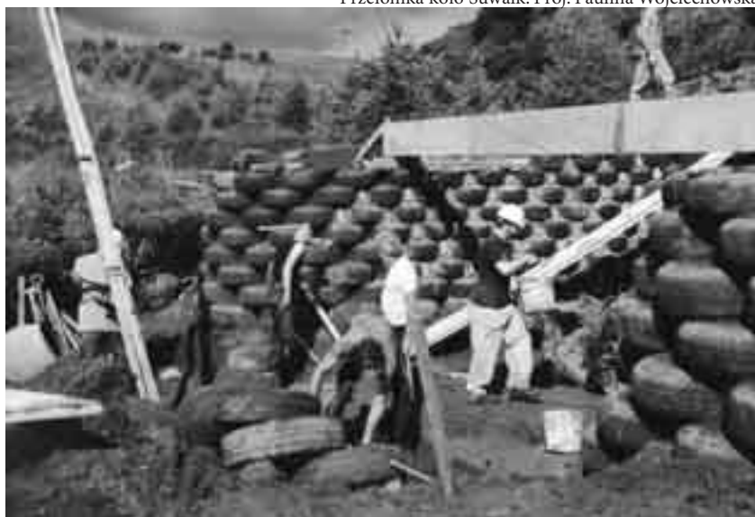
Budowa pierwszego we Wielkiej Brytanii Earthship (Statku-Ziemi), czyli samowystarczalnego budynku z opon. Proj. Michael Reynolds.
